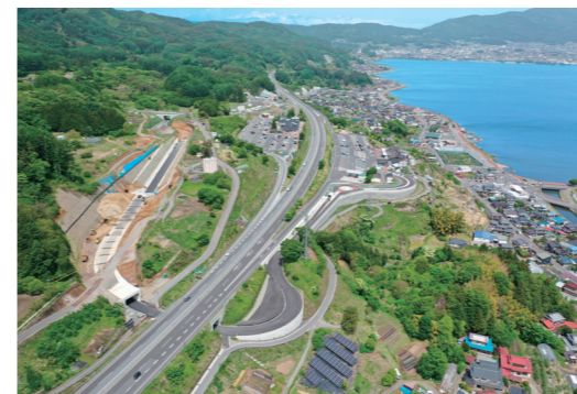
2025年7月27日開通予定の諏訪湖スマートインターチェンジ周辺
