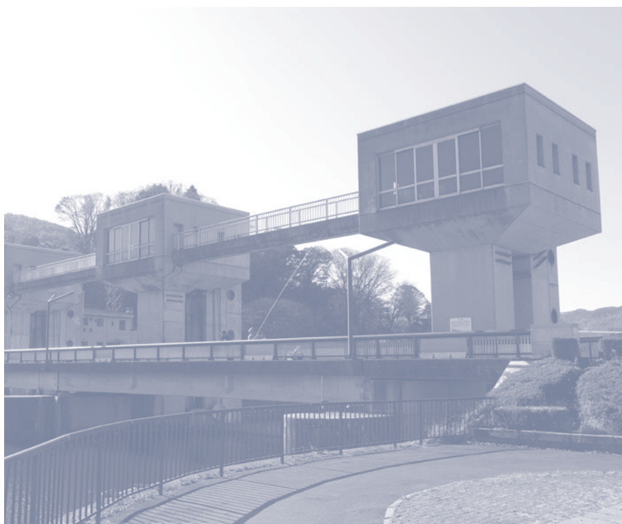
釜口水門 (岡谷市)
